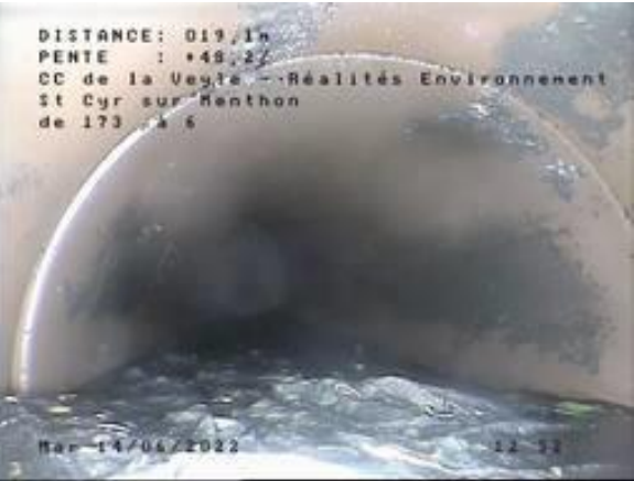
Dépôts important empêchant le bon écoulement des effluent
