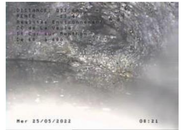
Dépôts bouchant complètement la canalisation
