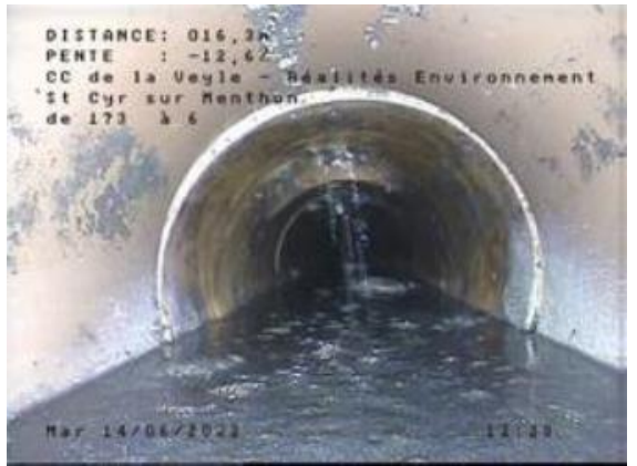
Ecoulement d'eaux claires en provenance d'un branchement
