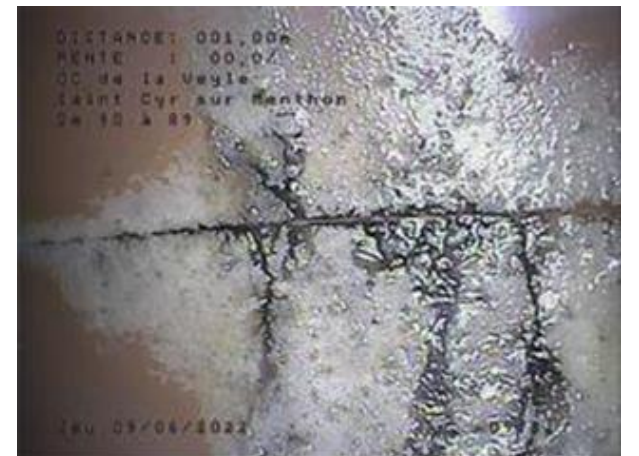
Fissure avec infiltration
