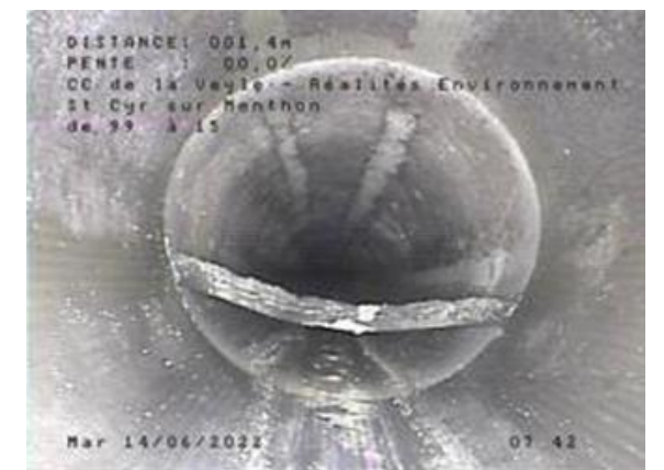
Joint d'étanchéité bloquant le passage caméra
