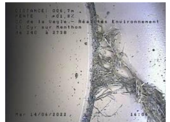
Racines dans les jonctions des canalisations
