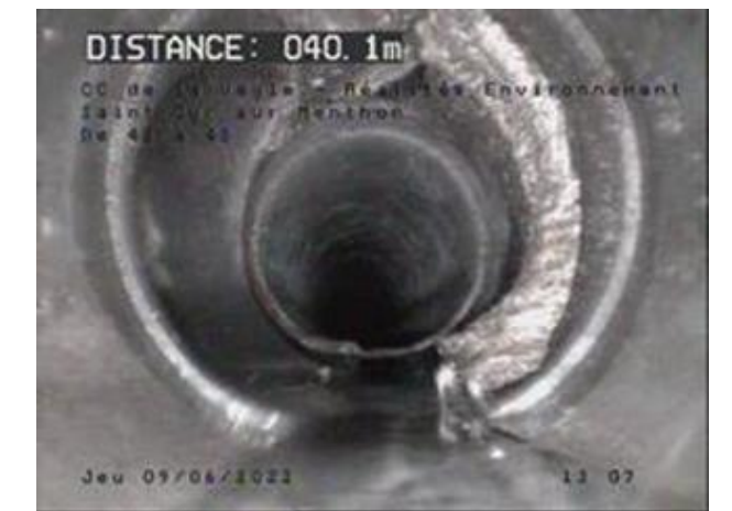
Rupture avec concrétions
